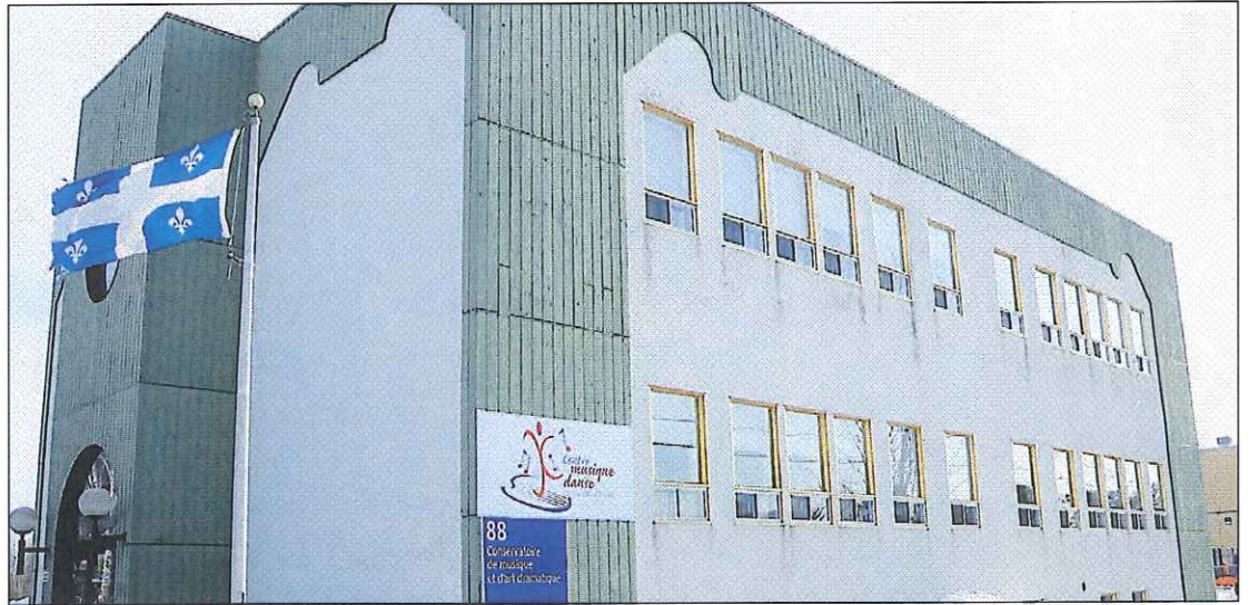
Dès la fin du printemps ou au début de l'été, les travaux s'amorceront pour revampier le Centre de musique et de danse, ainsi qu'amorcer la construction du nouveau Conservatoire de musique de Val-d'Or.
